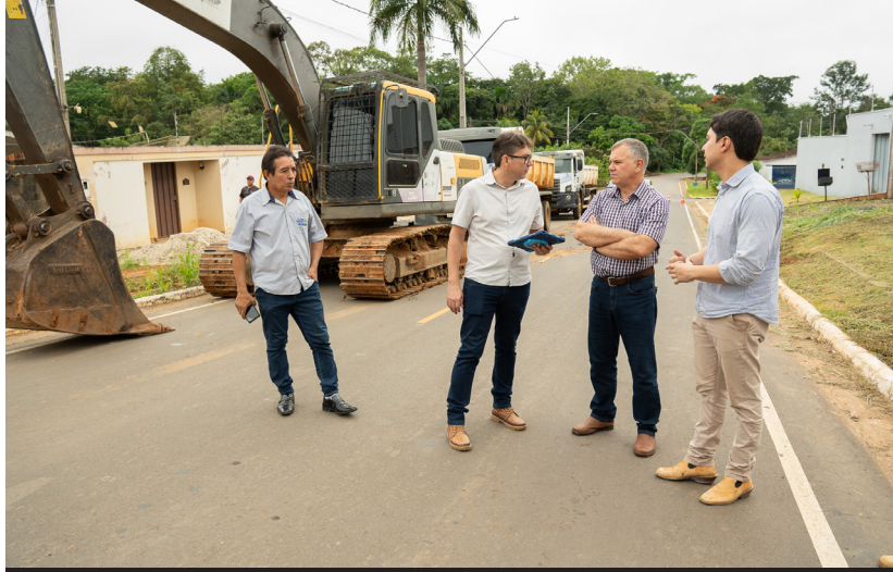
Prefeito Jeverson Lima e o deputado federal Lúcio Mosquini acompanharam os trabalhos de duplicação
